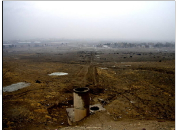
Trasse vom Wasserspeicher zur Siedlung im Tal
