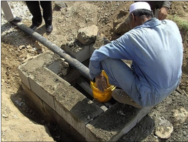
Abnahme der Wasserleitung
