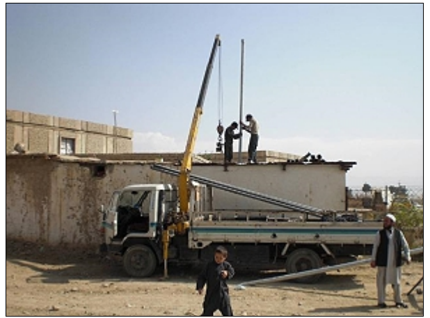
Montage der Saugleitung
